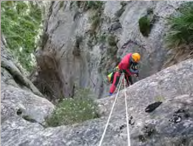
Instalación del rápel de 18m
